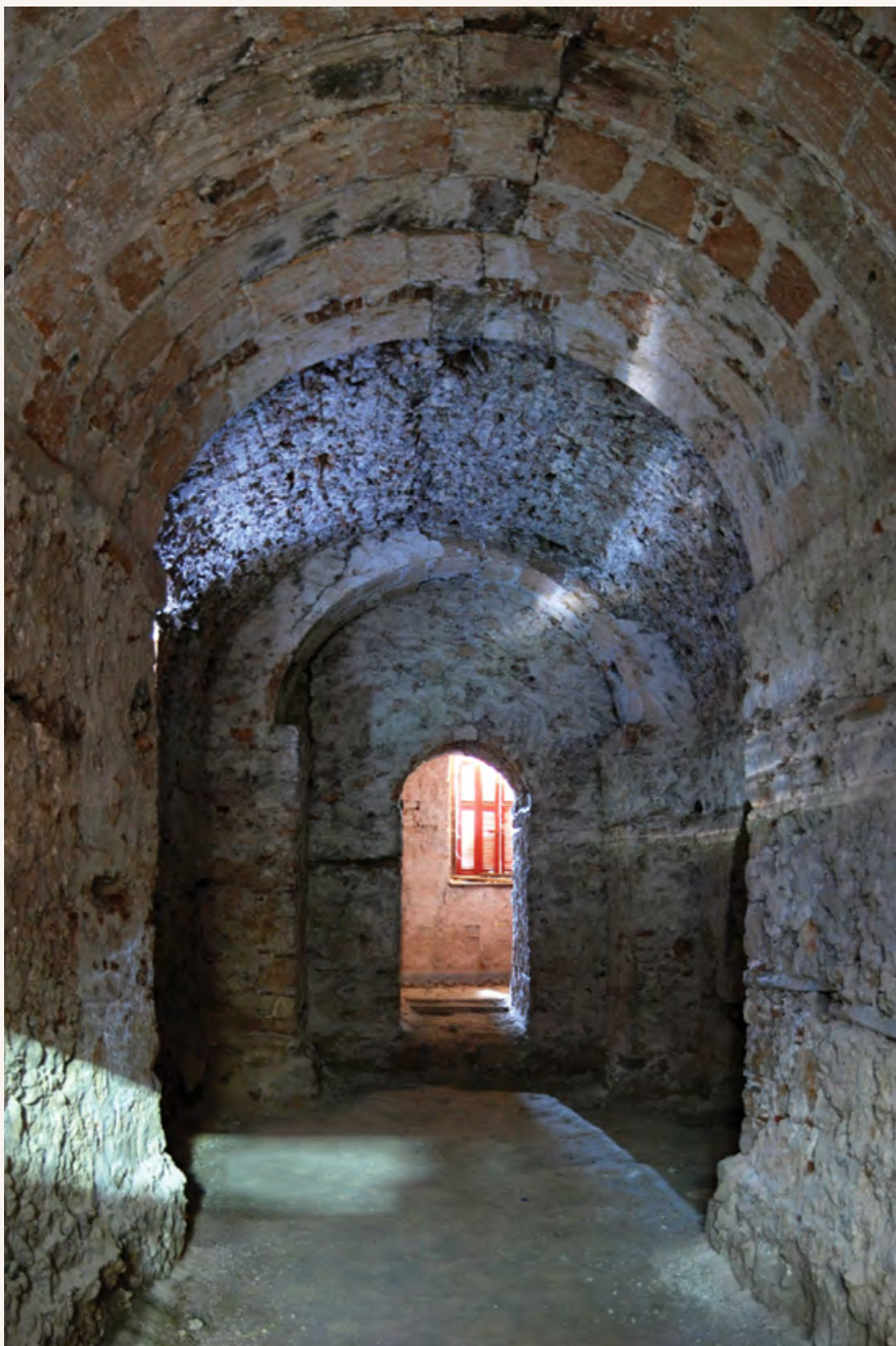
Εικ. 3: Ο λιθόκτιστος θόλος του αρχικού κτίσματος του Χασεκή στο ισόγειο του κτιρίου Κριμπά
