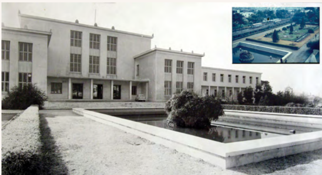
Εικ. 4: Το κεντρικό κτίριο της ΑΓΣΑ με την ορθογωνική λίμνη που υπήρχε μέχρι τη δεκαετία του 1980 στο προκήπιο
