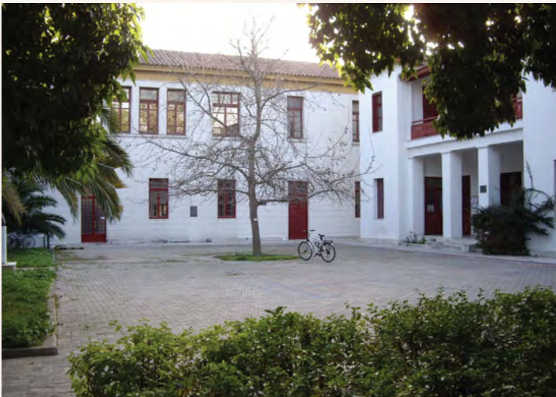
Εικ. 7: Το κτίριο Τριανταφυλλίδη
