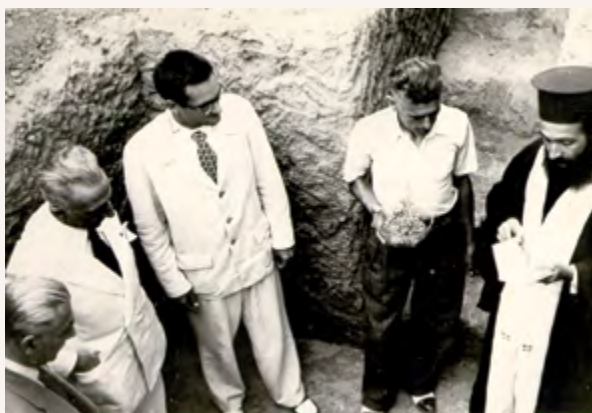
Εγκαίνια στα θεμέλια του κεντρικού κτιρίου
